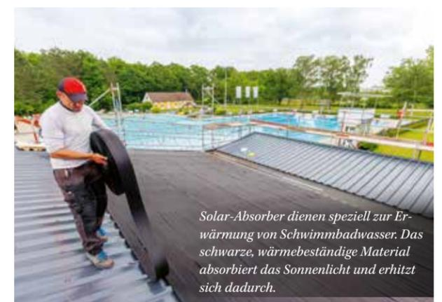
Solar-Absorber dienen speziell zur Erwärmung von Schwimmbadwasser. Das schwarze, wärmebeständige Material absorbiert das Sonnenlicht und erhitzt sich dadurch.
