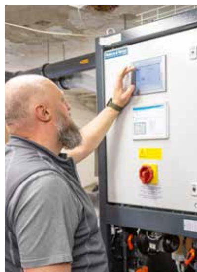
Die neue Doppelanlage mit 24 und 36 Kilogramm Tagesleistung erzeugt täglich bis zu 60 Kilogramm Desinfektionsmittel. So bleibt die Wasseraufbereitung auch dann zuverlässig, wenn ein System gewartet werden muss.
