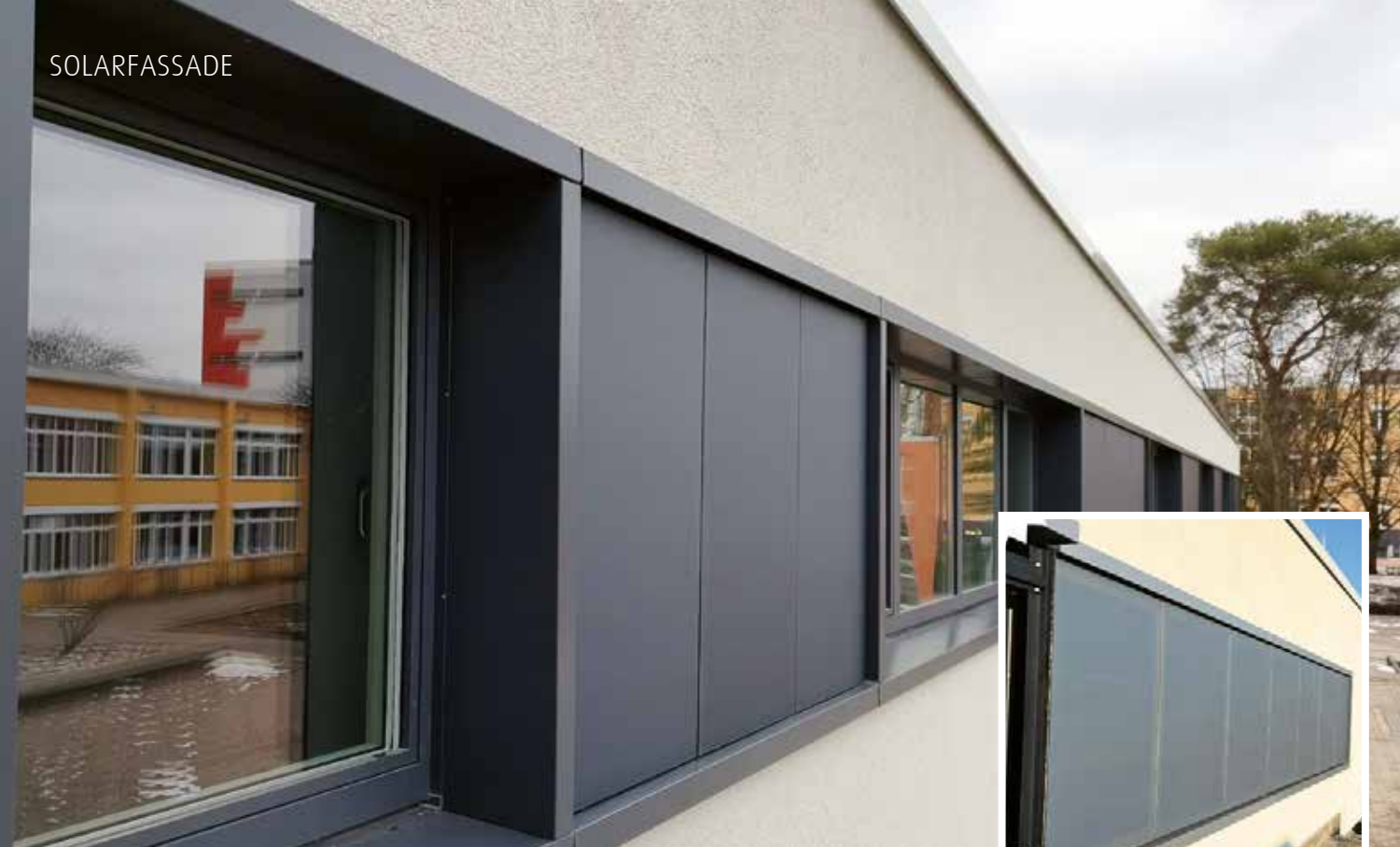
Die Montage der Spezialmodule am alten Hölty-Gymnasium ist abgeschlossen – voraussichtlich im Spätsommer wird die Anlage in Betrieb genommen.
